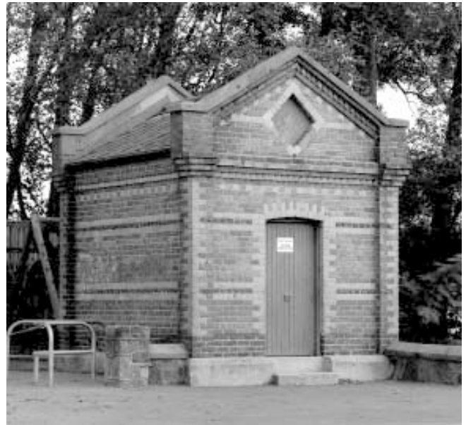
Woodham Park MED Substation
