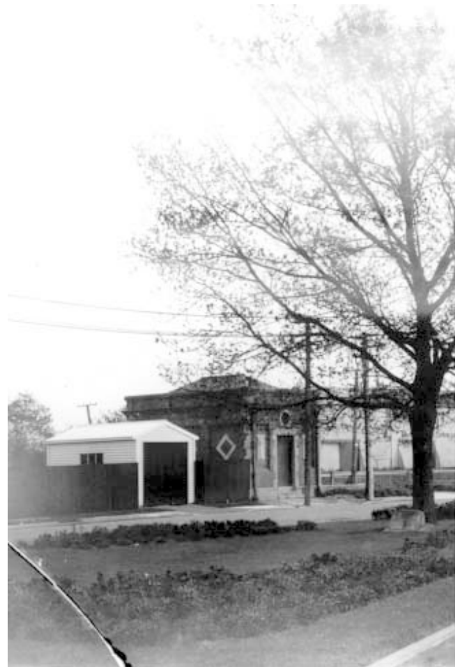
Ensors Road MED Substation
