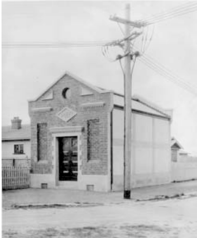
Seddon Street MED Substation
